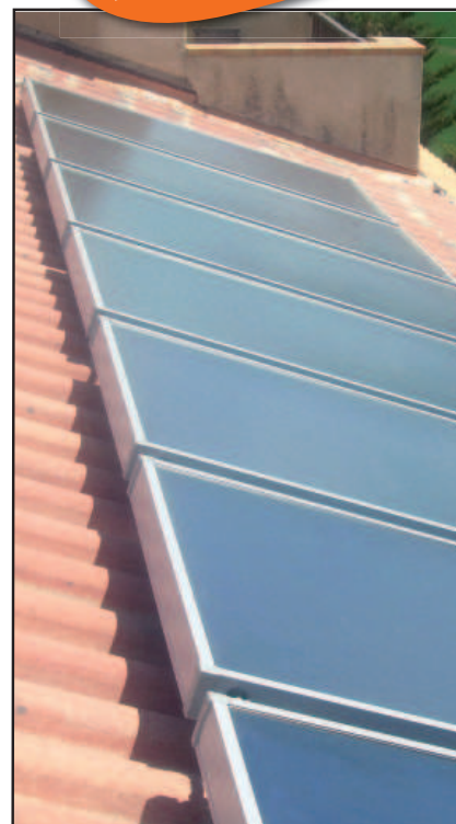
pose en sur-toiture
